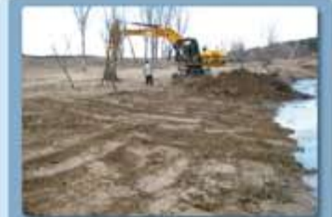
Reperfilado de orillas para mejorar los procesos de sedimentación.
