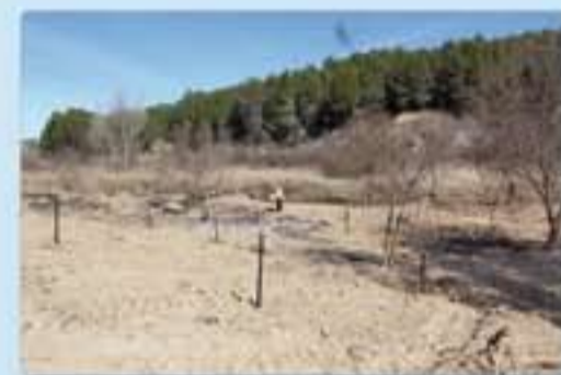
Durante las obras
