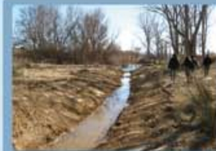
Creación de canal secundario a través de la llanura de inundación.
