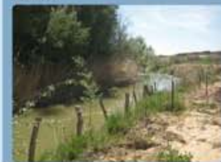
Técnicas de bioingeniería para la estabilización de riberas mediante empalizadas de sauce.
