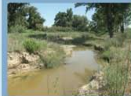
Creación de canal secundario a través de la llanura de inundación.
