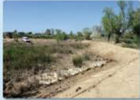
Durante las obras - Abril 2013
